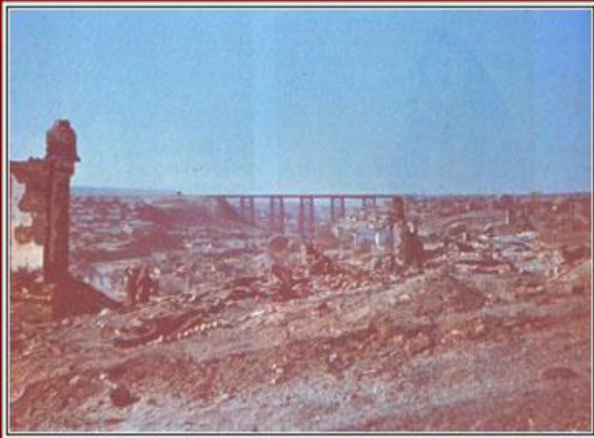
Разрушения в Сталинграде, октябрь 1942г.
