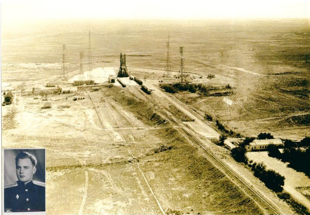
Первый космический старт Земли (ПУ-1, сооружение I площадки 1 Байконура. «Козырёк» «Гагаринский старт»)
