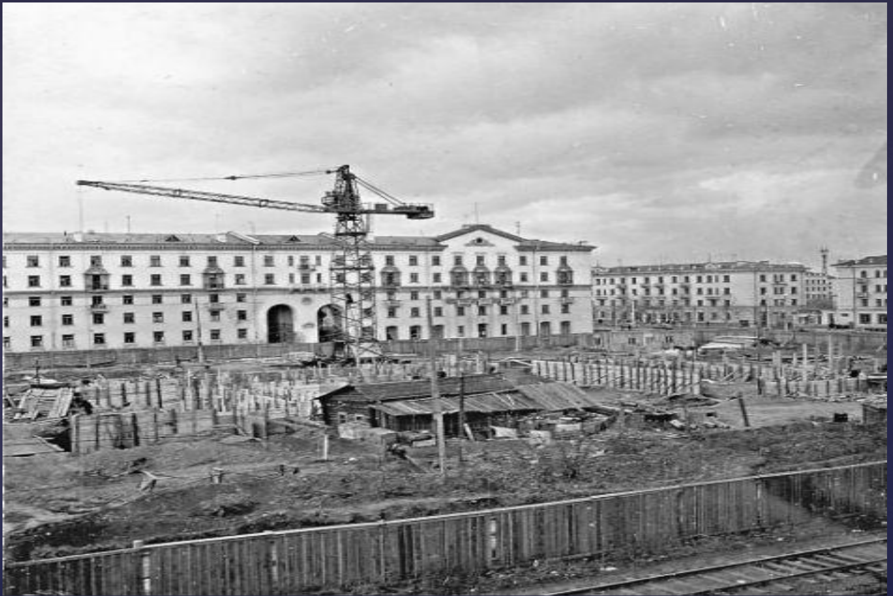
Строительство драматического театра
