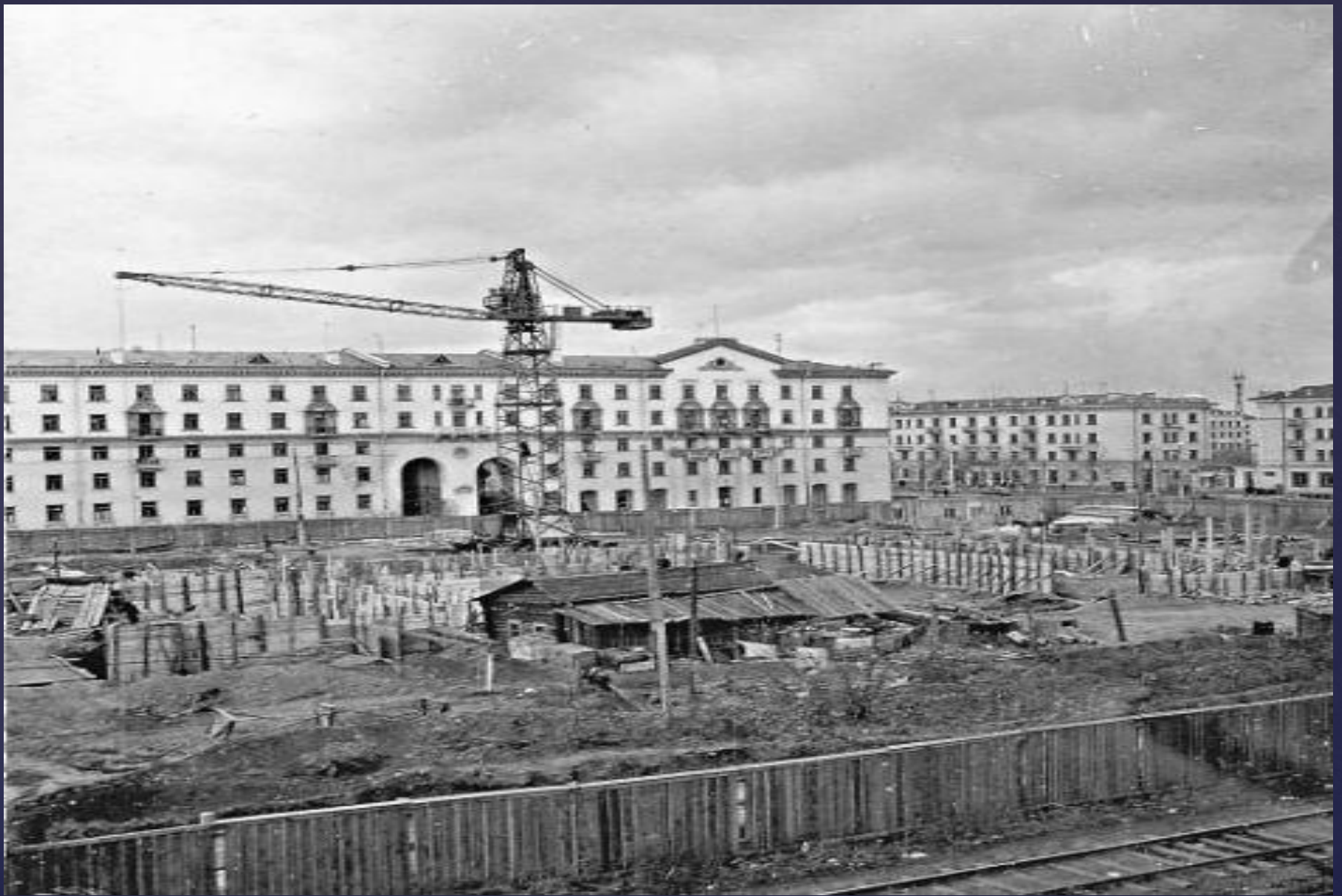
Строительство драматического театра
