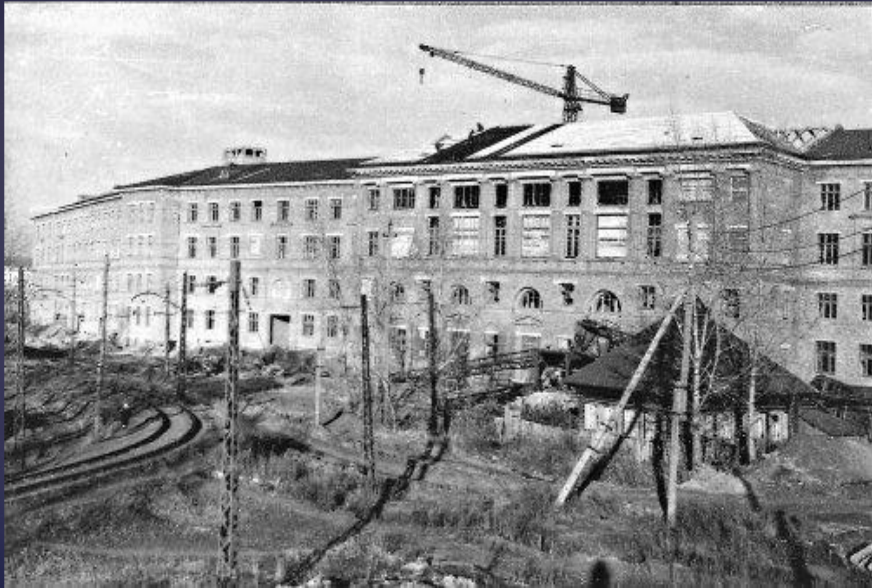
Строительство Политехнического института
