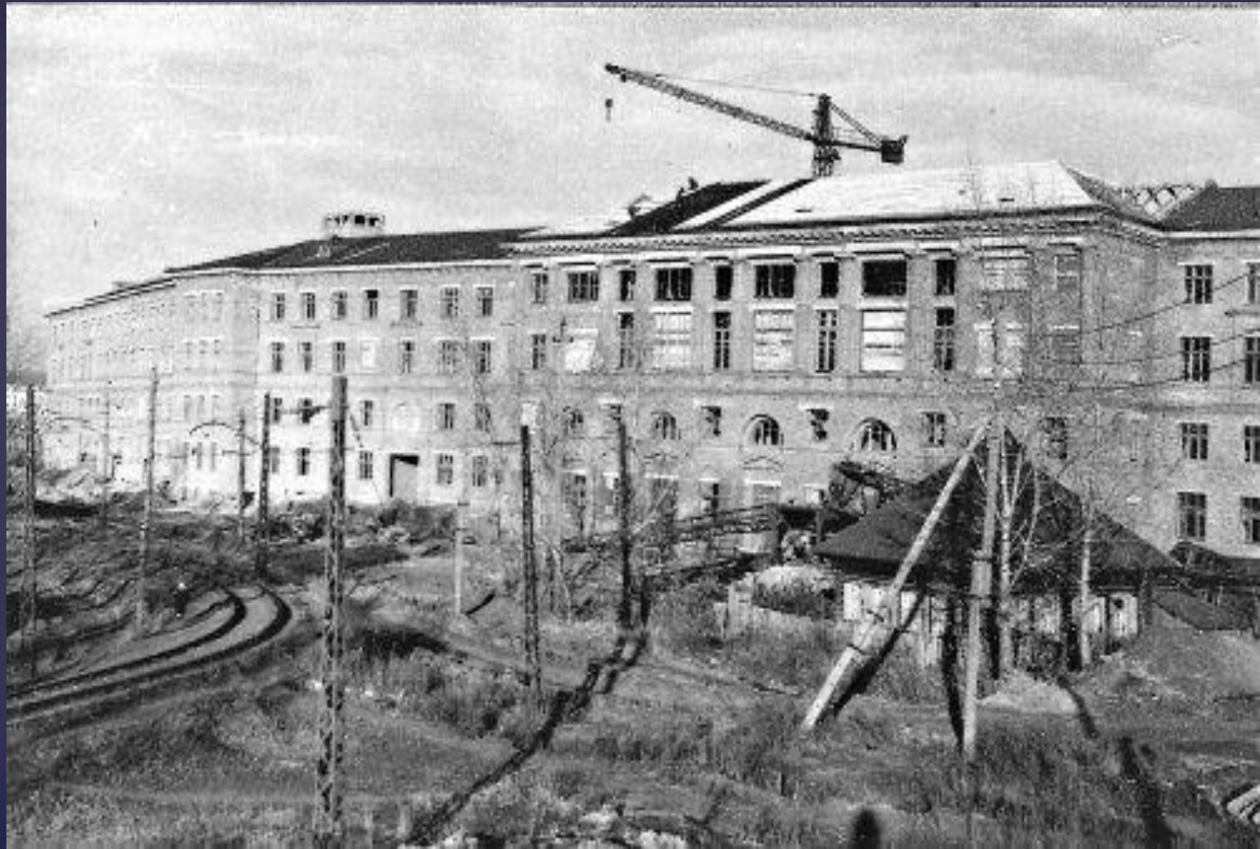
Строительство Политехнического института
