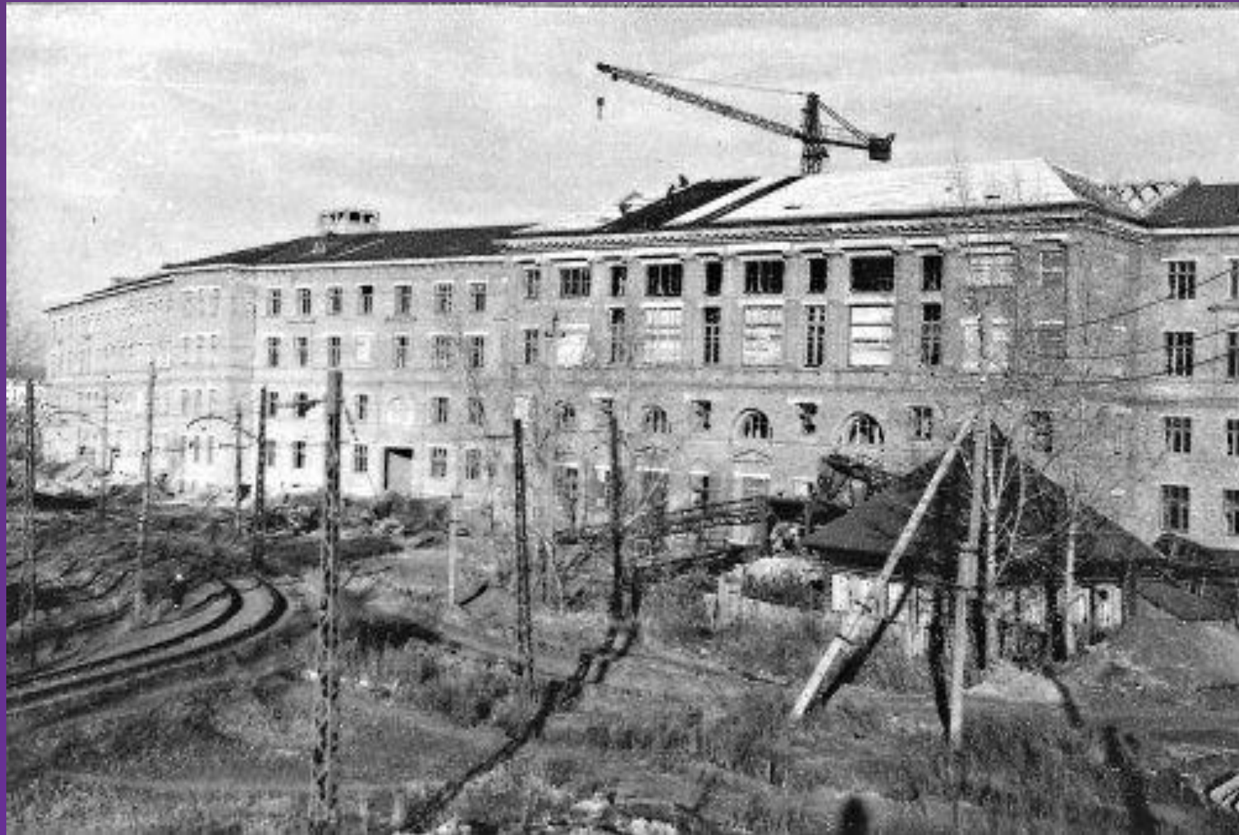
Строительство Политехнического института
