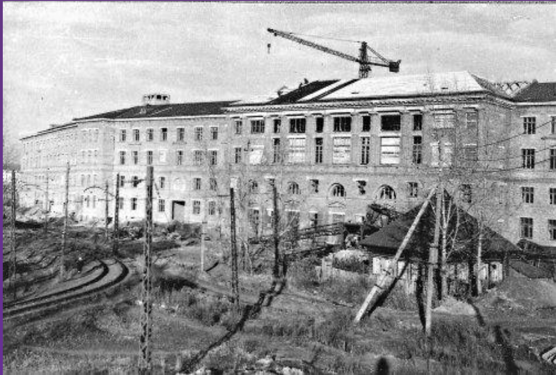
Строительство Политехнического института
