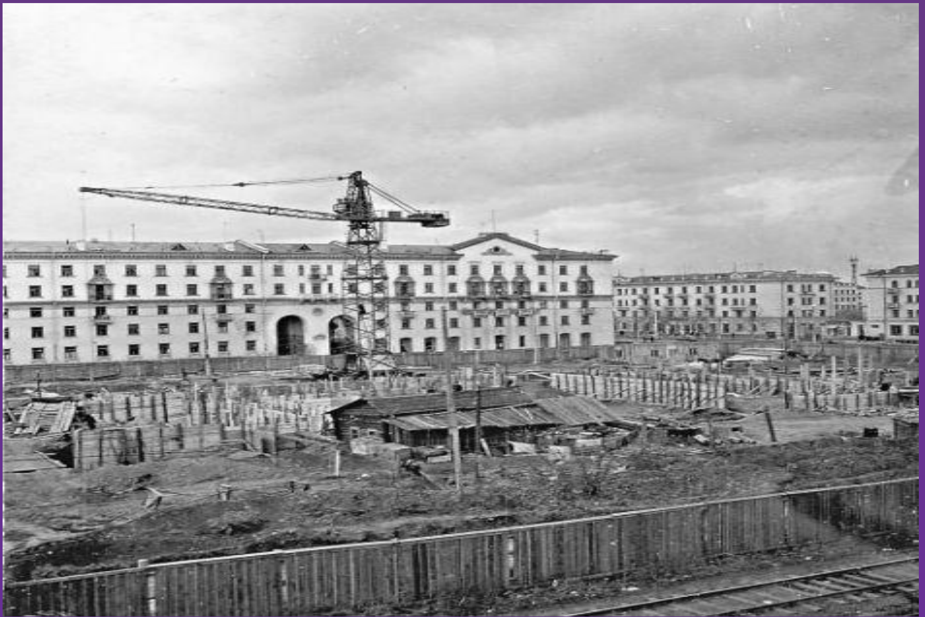
Строительство драматического театра
