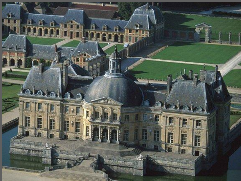
Луи Лево, Андре Ленотр. Во-ле-Виконт 1656—1661. Парковый фасад.
