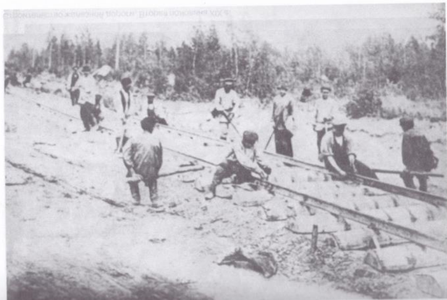
Строительство железной дороги. Вторая половина XIX в.
