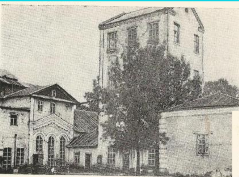
Ромодановский спиртзавод. Слева виден фасад старинного заводского корпуса.
