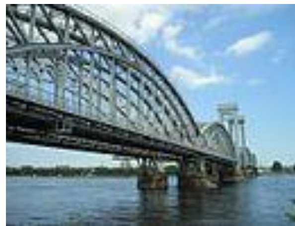
Финляндский железнодорожный мост
