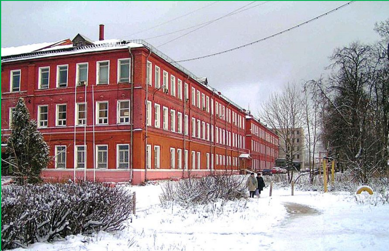
Конаковский фарфоровый завод
