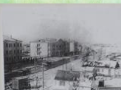
Строительство жилых домов на улице Мещанова.
