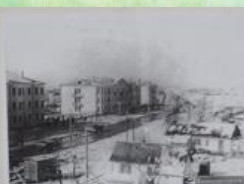
Строительство жилых домов на улице Мещанова.
