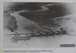
Строительство Главного Спортивного 40-50-е годы.
