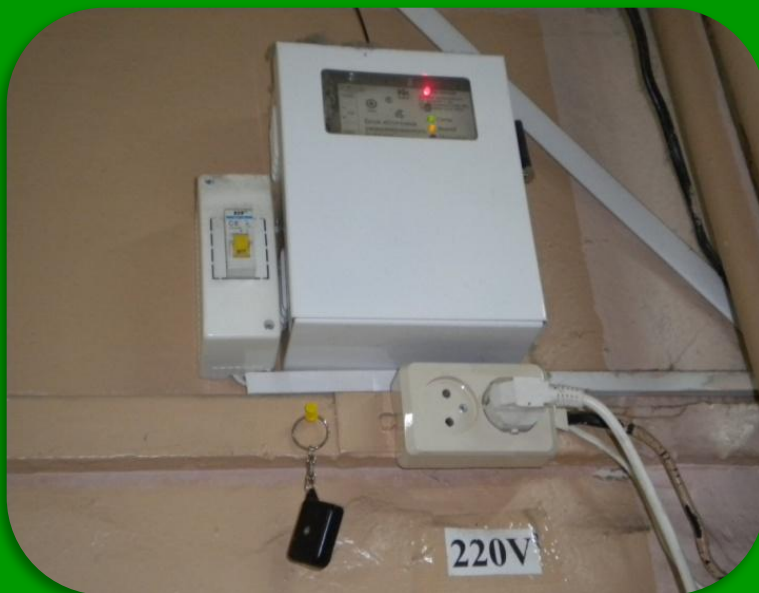
Система безопасности: Пожарная и охранная сигнализации
