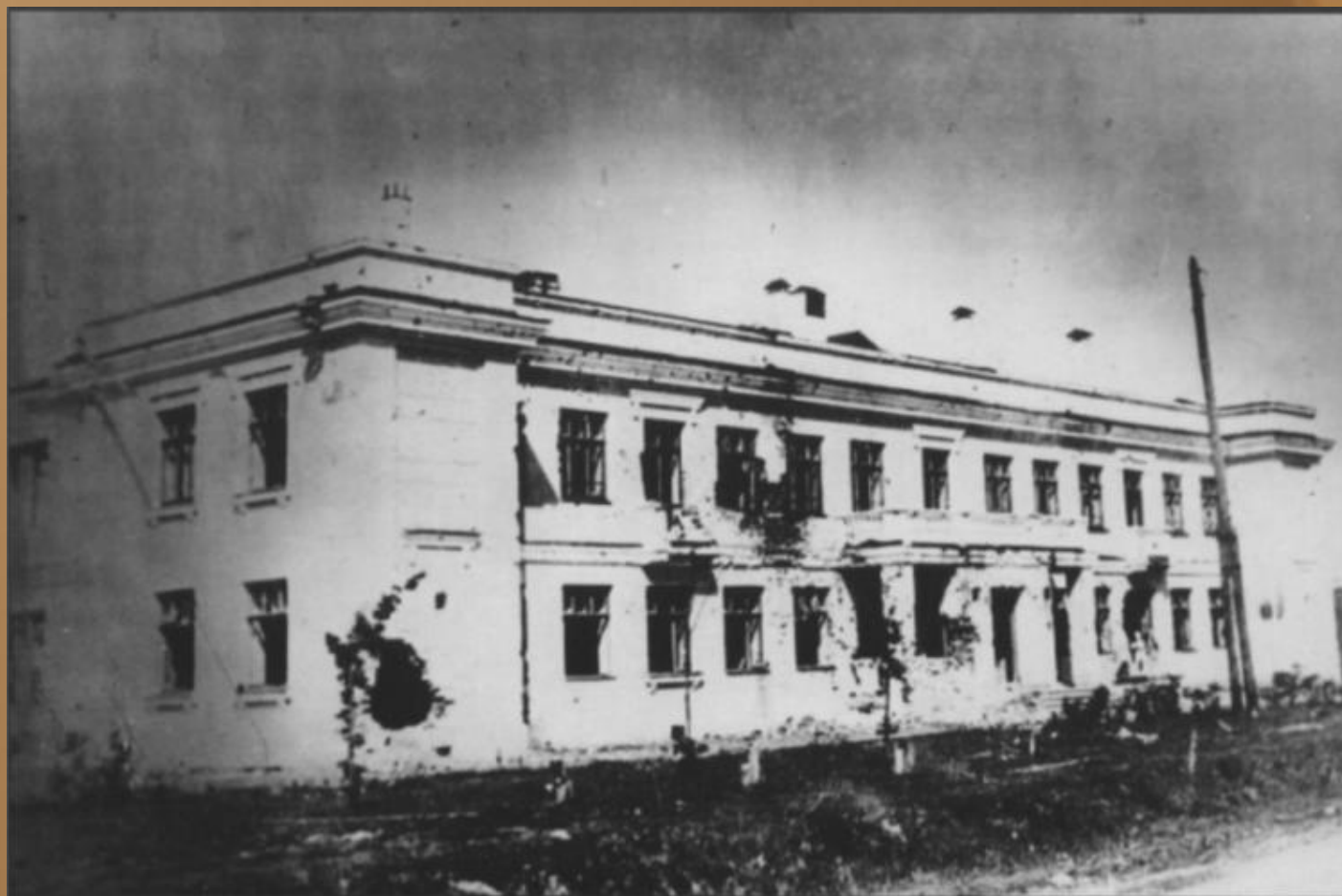
Здание детских яслей на улице Парловской, 1942 г.
