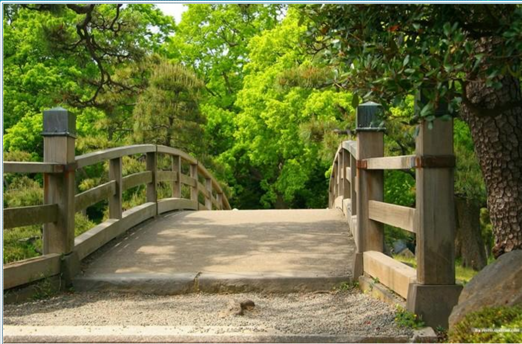
Деревянный мост через глубокий овраг
