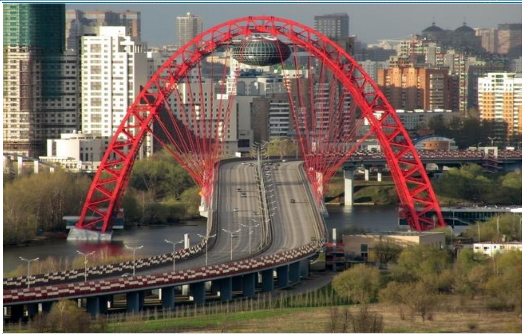
Живописный мост г.Москва
