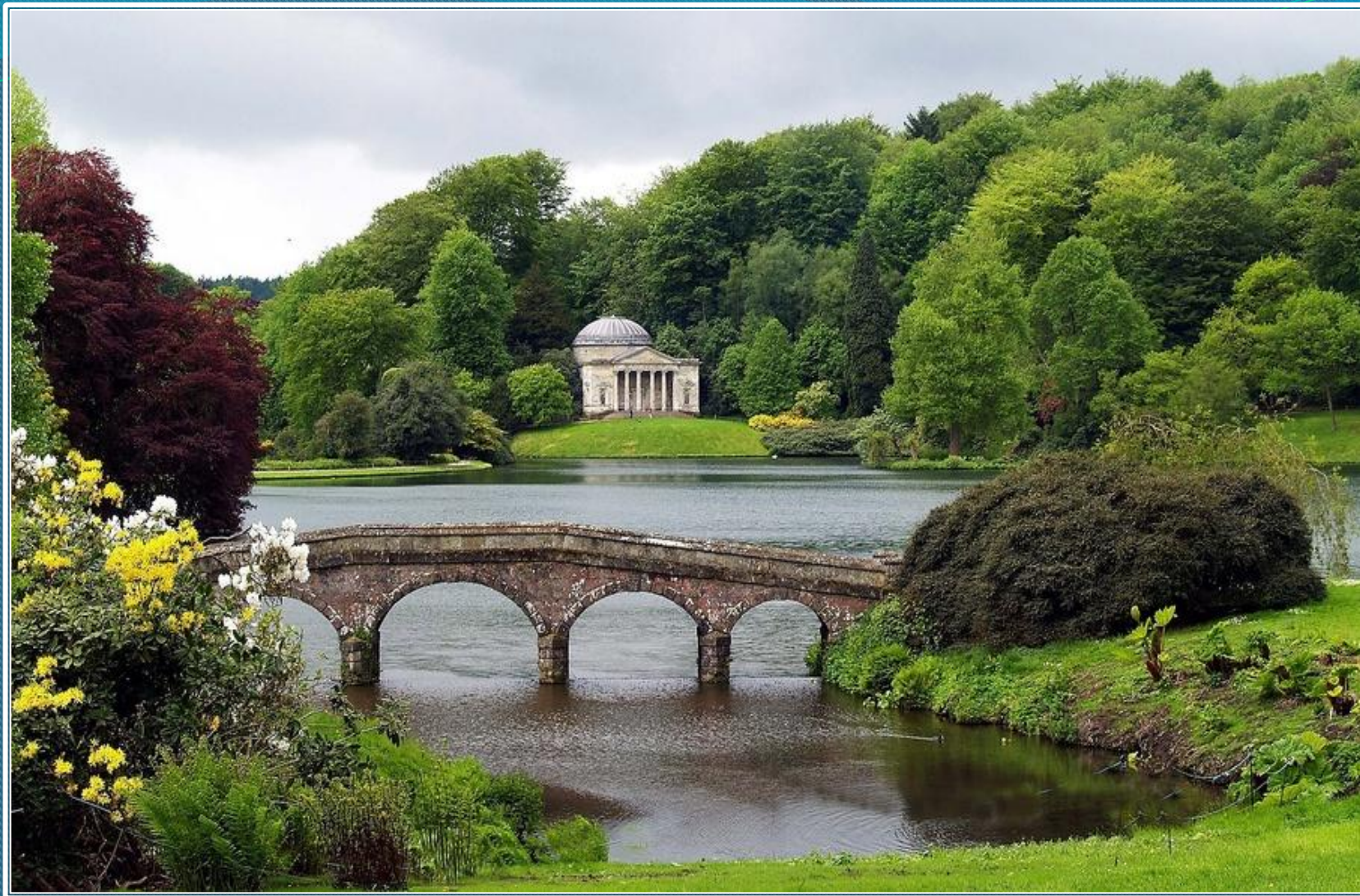
Каменный мост через реку
