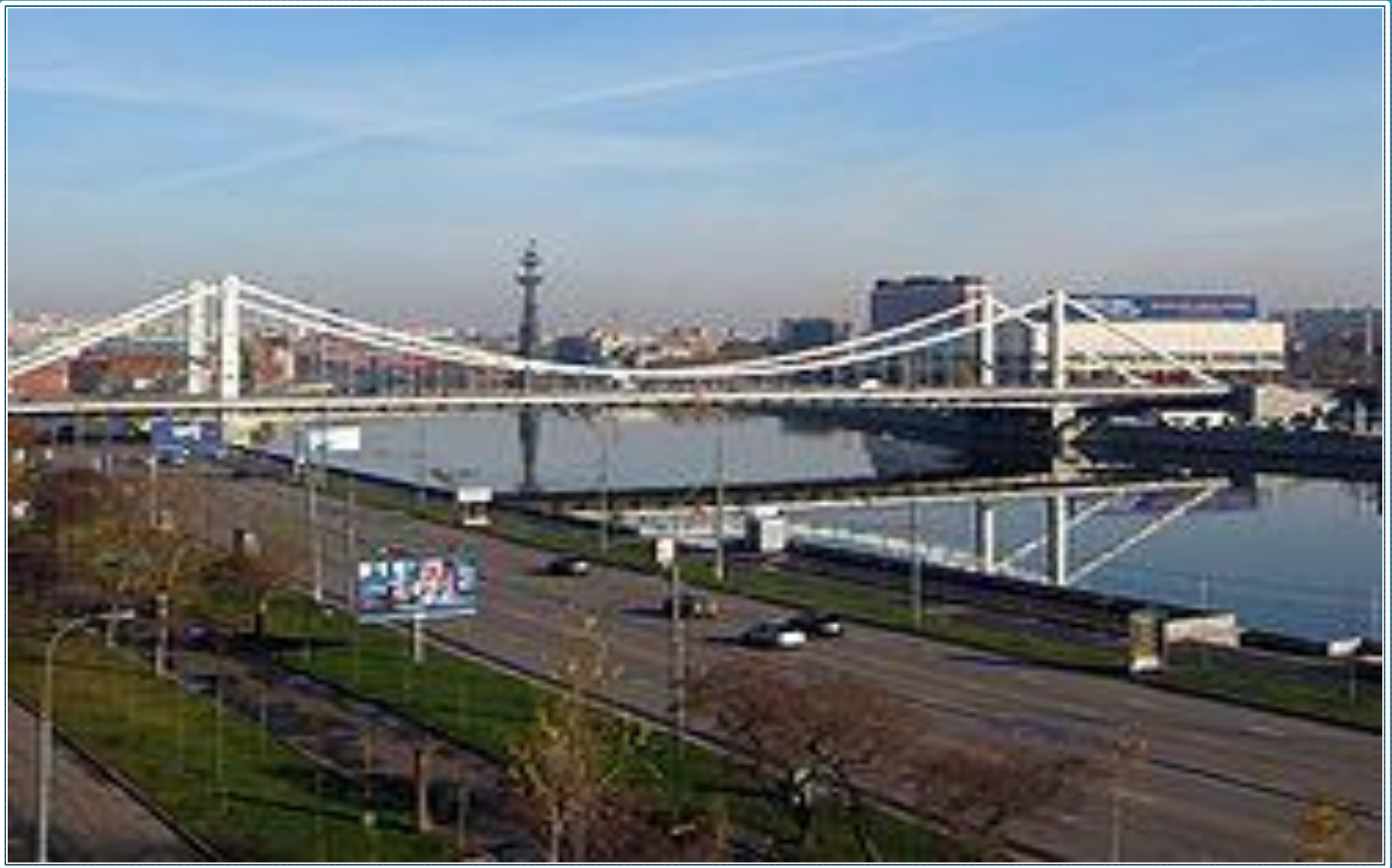
Крымский мост г. Москва
