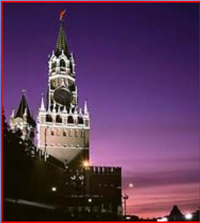
Спасская башня- главная башня Московского Крем- ля.
