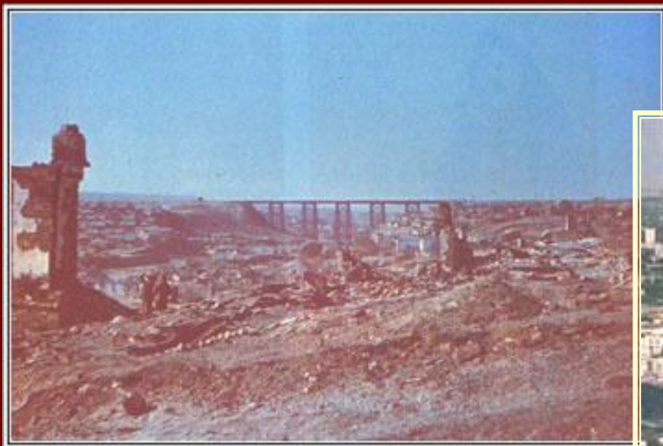
Разрушения в Сталинграде, октябрь 1942г.
