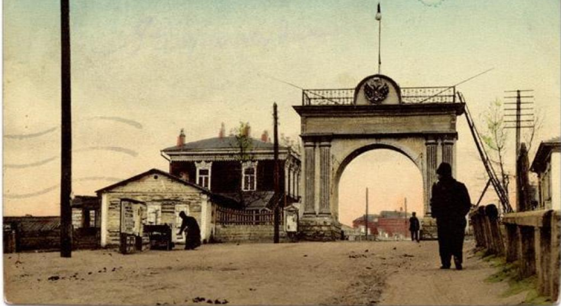
г. Верхнеудинскъ. Царскія ворота съ южной стороны.
