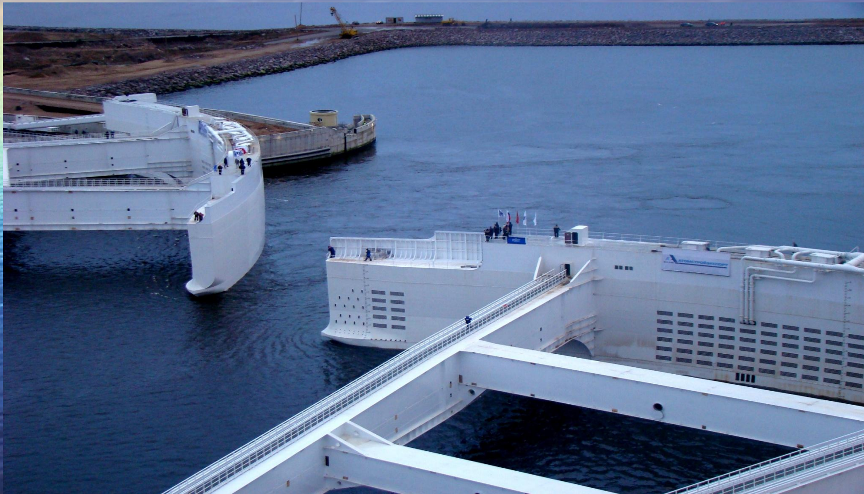
Рис.9 - Угроза наводнения (створки ворот начинают закрывать отверстие, чтобы волна не пошла на город)
