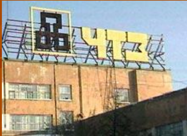
ООО «Челябинский Тракторный Завод»
