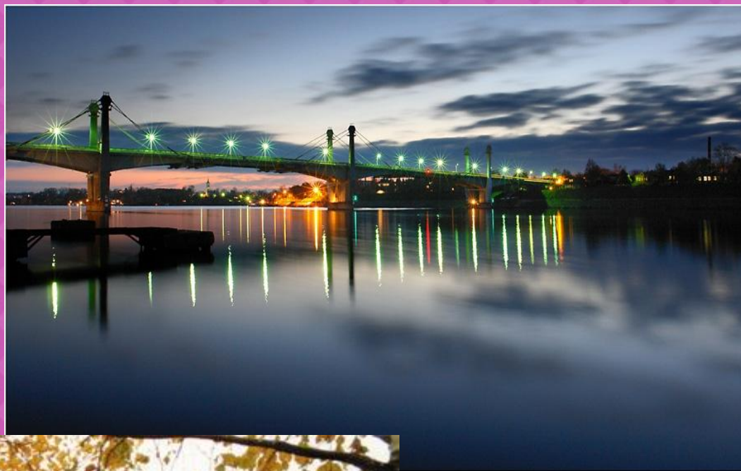
Мост через р.Волга
