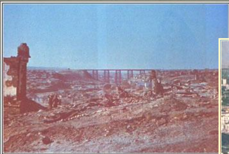
Разрушения в Сталинграде, октябрь 1942г.
