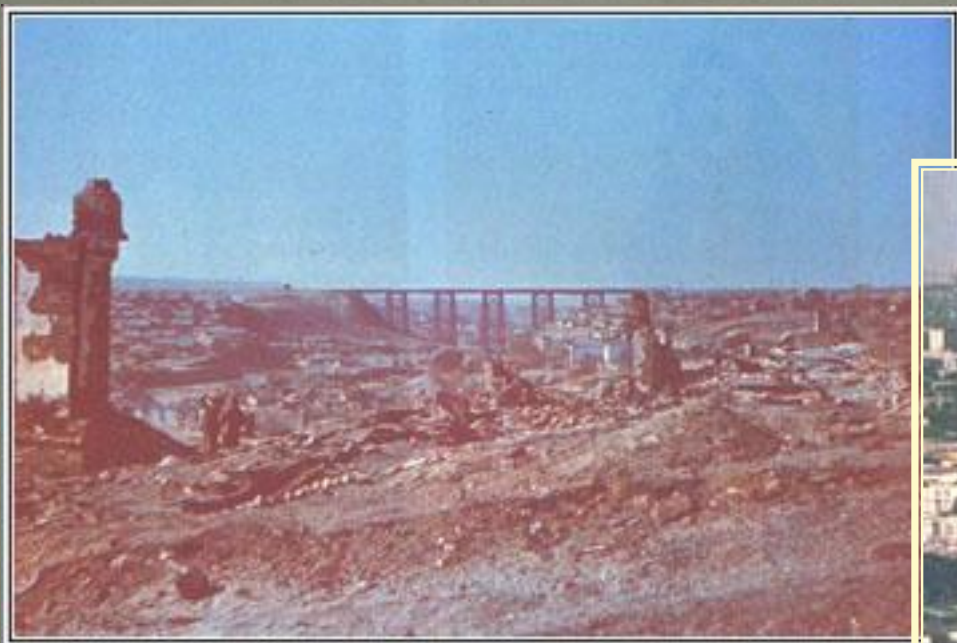
Разрушения в Сталинграде, октябрь 1942г.
