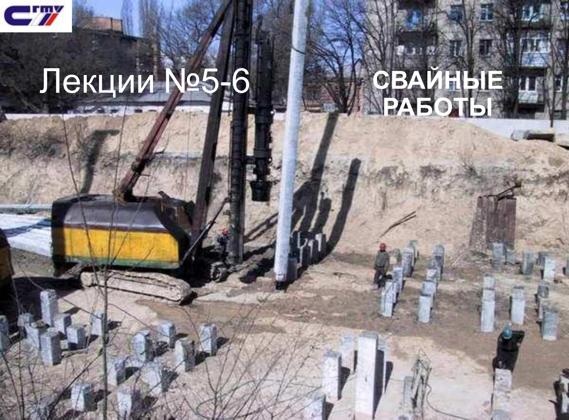
**Сваи** предназначены для передачи нагрузки от здания или сооружения на грунты, повышения несущей способности слабых грунтов, ограждения пространств от доступа воды, предотвращения осыпания или оползания грунтов.
