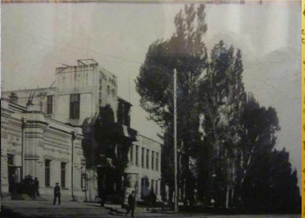
ТАШКЕНТ, КЮЙЛЮКСКАЯ УЛ. ТЕЛЕФ. СТАНЦИЯ
