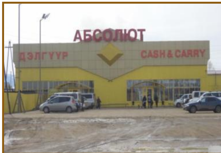
Торговый центр «Абсолют»
