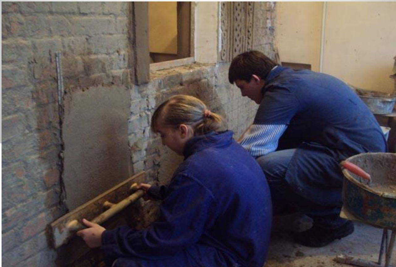
**Разравнивание раствора на поверхности полутёрком**
