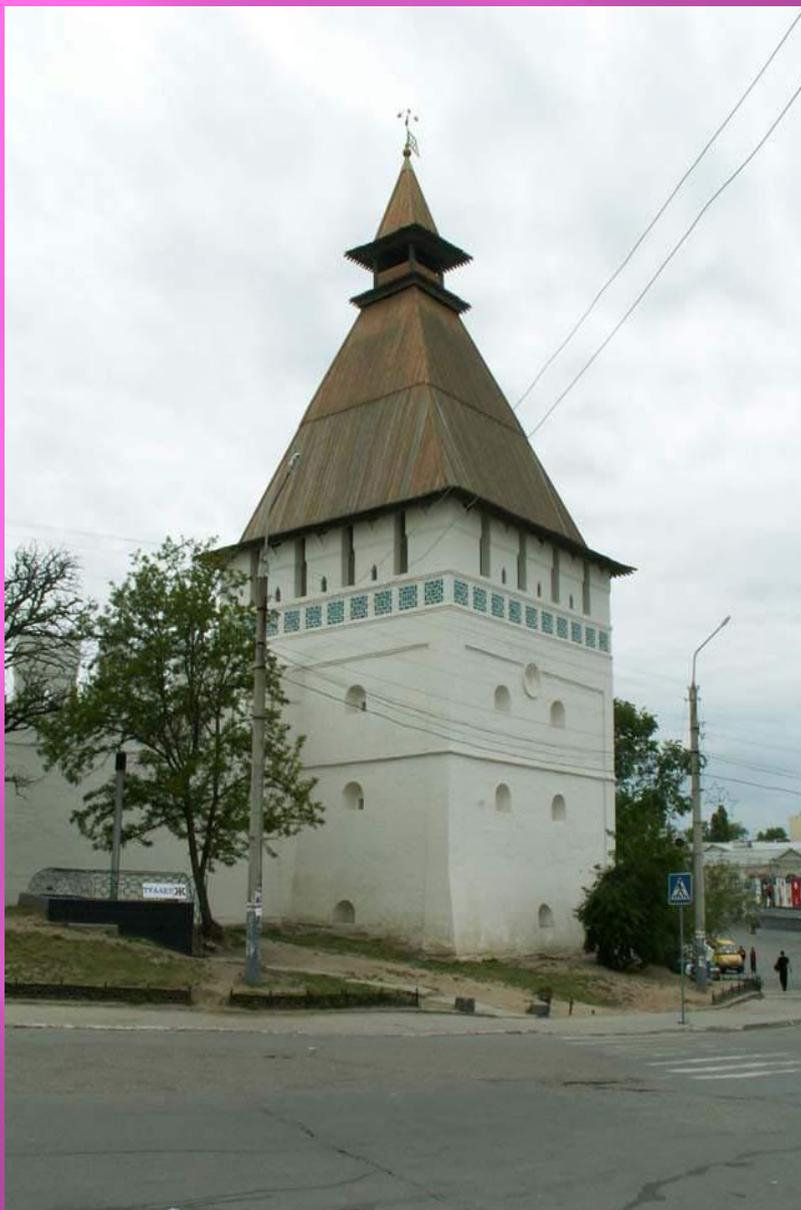
Артиллерийская башня. Северо-восточная угловая глухая башня, третья сохранившаяся башня XVI века. В плане ромбовидная 12,7 x 12,3 м., высота с зубцами около 16 м., четырехъярусная, имеет 15 бойниц, завершается пятью зубцами с каждой стороны.
