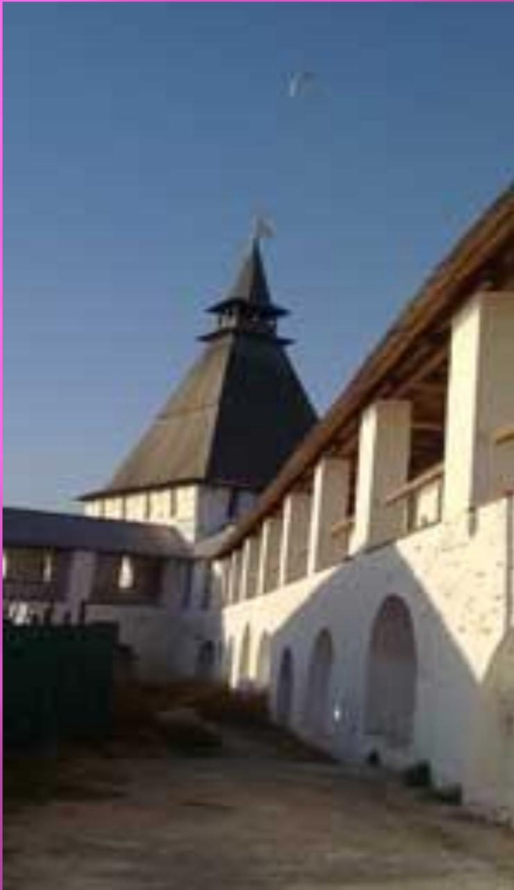
Крымская башня. Одна из трех сохранившихся в исторических формах XVI века башен кремля. Пятиярусная, имеет 20 бойниц, в плане ромбовидная 12,8x13,2 м. Ее высота с южной стороны от земли до зубцов достигает 17 м. Вход в башню устроен с прясла стены на уровне четвертого яруса, внутри стен каменные лестницы и только на первый ярус, который заглублен под землю, ведёт деревянная лестница. Ярусы разделены деревянными перекрытиями
