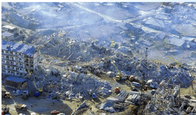
Землетрясение в Армении (г.Спитак), зима 1988 г.
