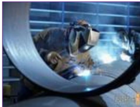
Монтажник стальных и железобетонных конструкций
