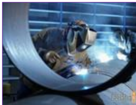
Монтажник стальных и железобетонных конструкций
