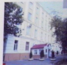
В сентябре 2002 г. был проведен современный ремонт в здании, который по началу и закончился весной.
