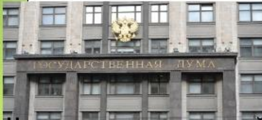
На зданиях госучреждений
