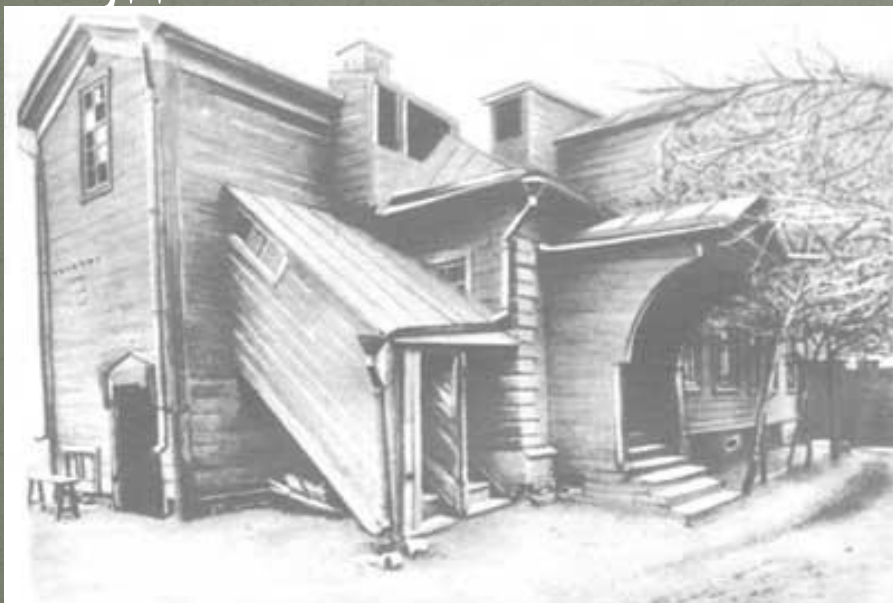
Дом Григорьевых в Замоскворечье. Малая Полянка, 12. Вид со двора. Фото 1915 г.
