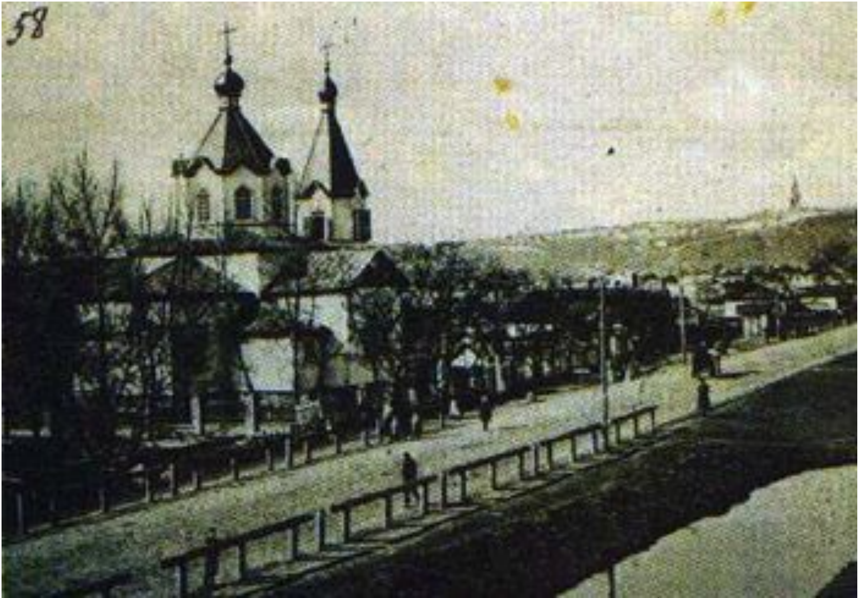
Свято-Никольский храм в Никольской Слободке. Храм был разрушен в 1961 году
