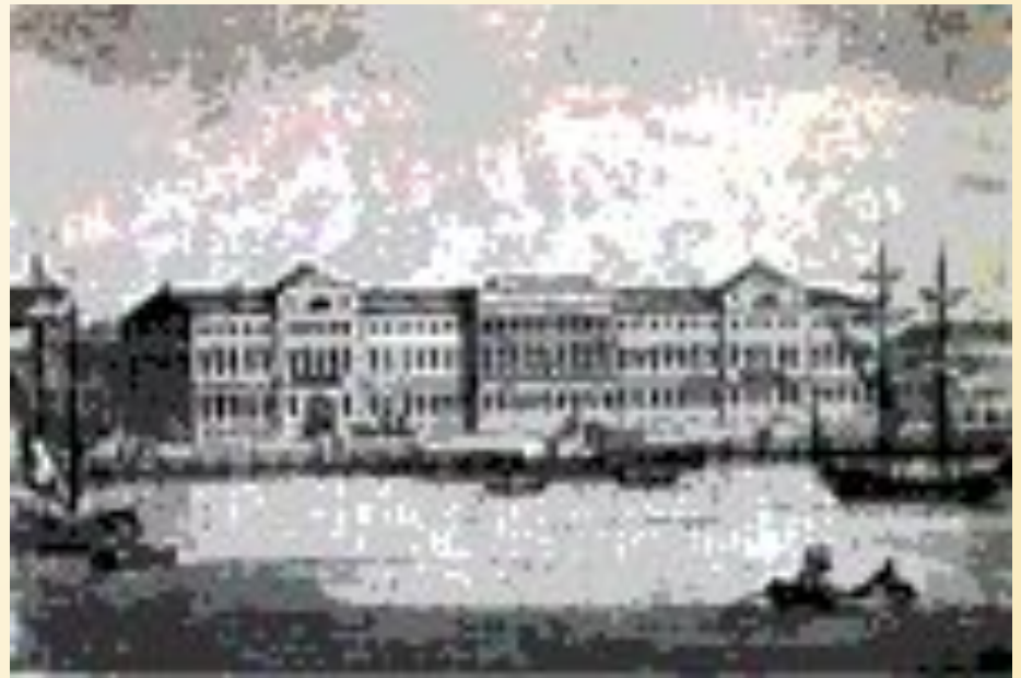
Здание Морского кадетского корпуса в Санкт-Петербурге.
