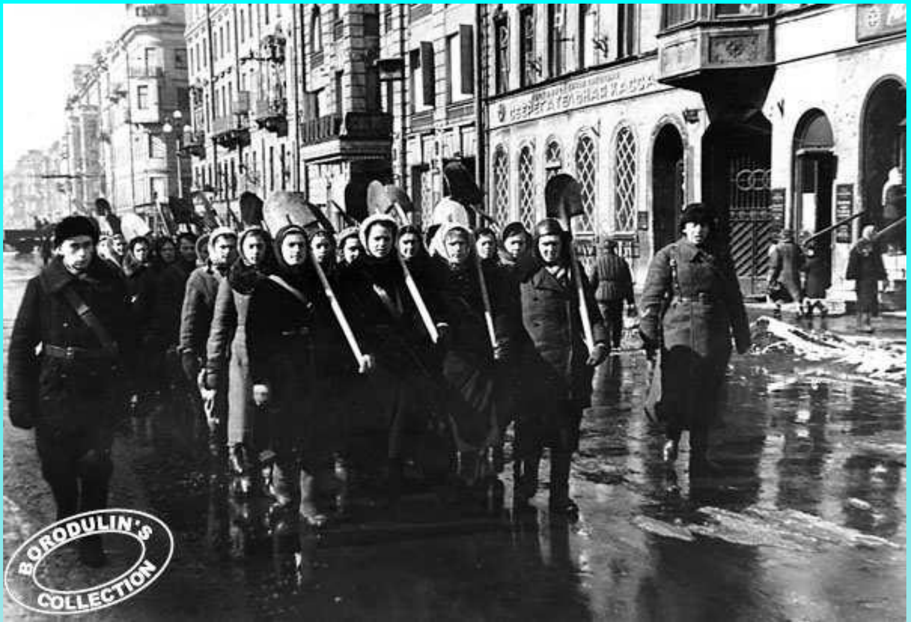
Женский строительный батальон.
