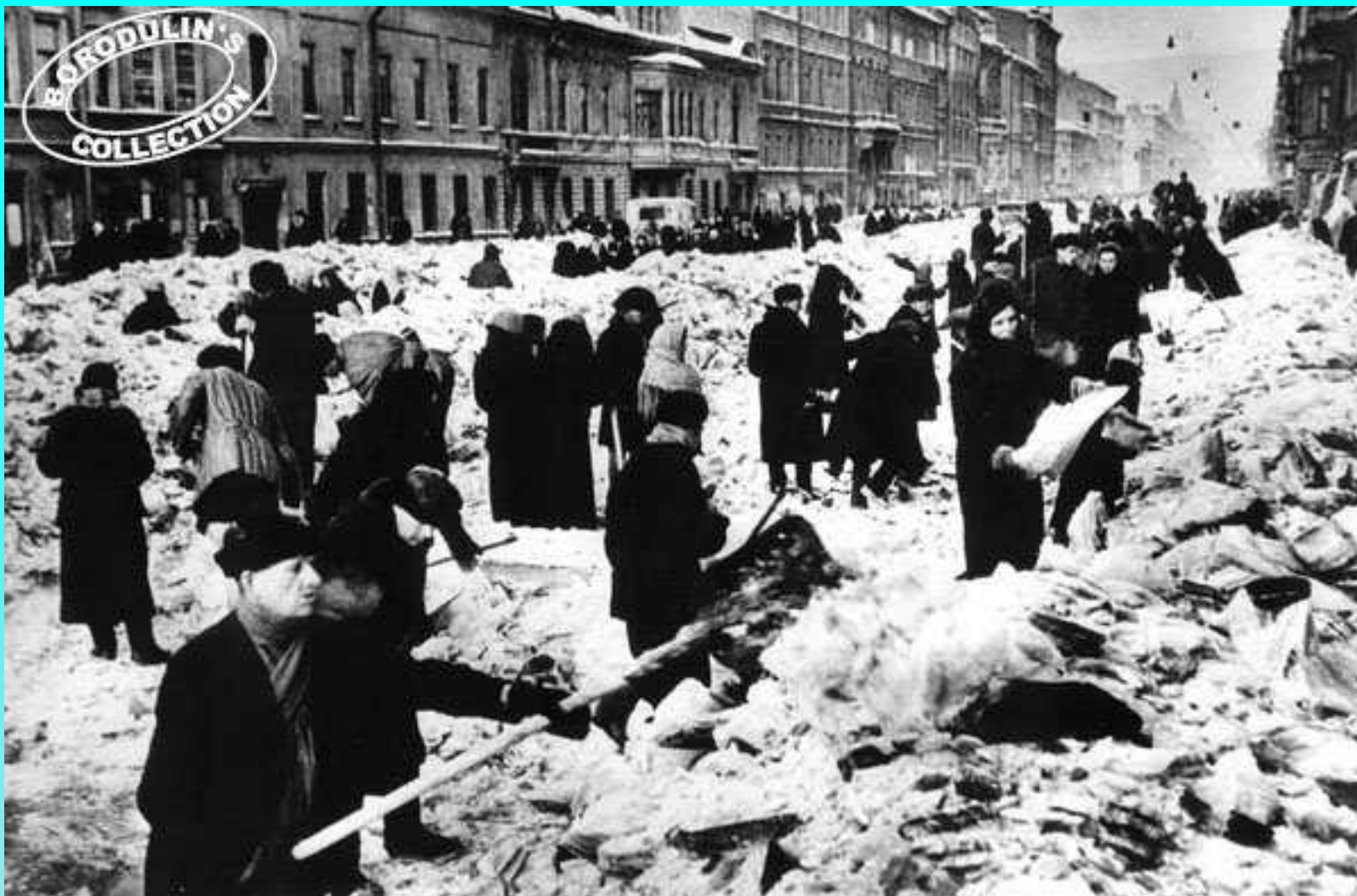
Восстановление Невского проспекта.
