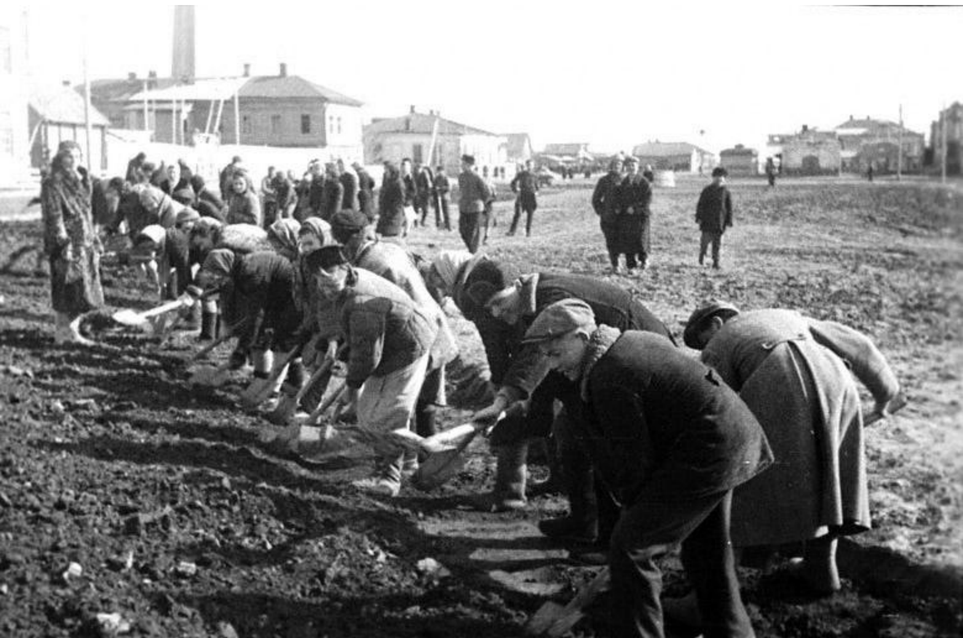
Учащиеся средней школы № 8 г.Новокузнецка за ремонтом дороги.1944 г.
