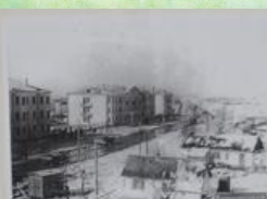
Строительство жилых домов на улице Механизаторов.
