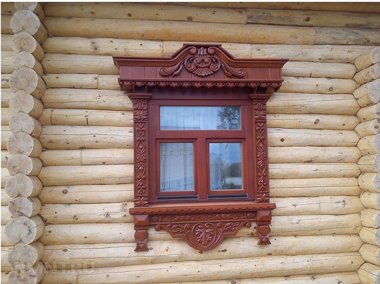
**Наличники — декоративное оформление оконного или дверного проёма в виде накладных планок или дощечек. Наличник прикрывает щель между стеной и оконной или дверной коробкой.**
