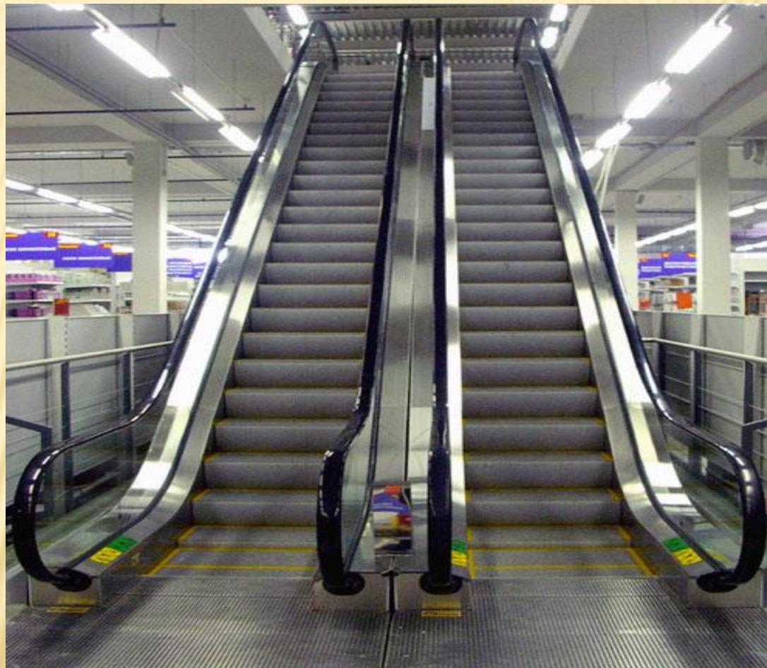
**Эскалатор** — подъёмно-транспортная машина в виде наклонённой на  $30\text{—}35^\circ$  к горизонту лестницы с движущимися ступенями для перемещения людей с одного уровня на другой.
