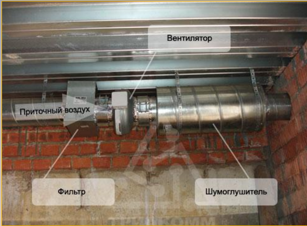
Типовой пример монтажа приточной вентиляции
