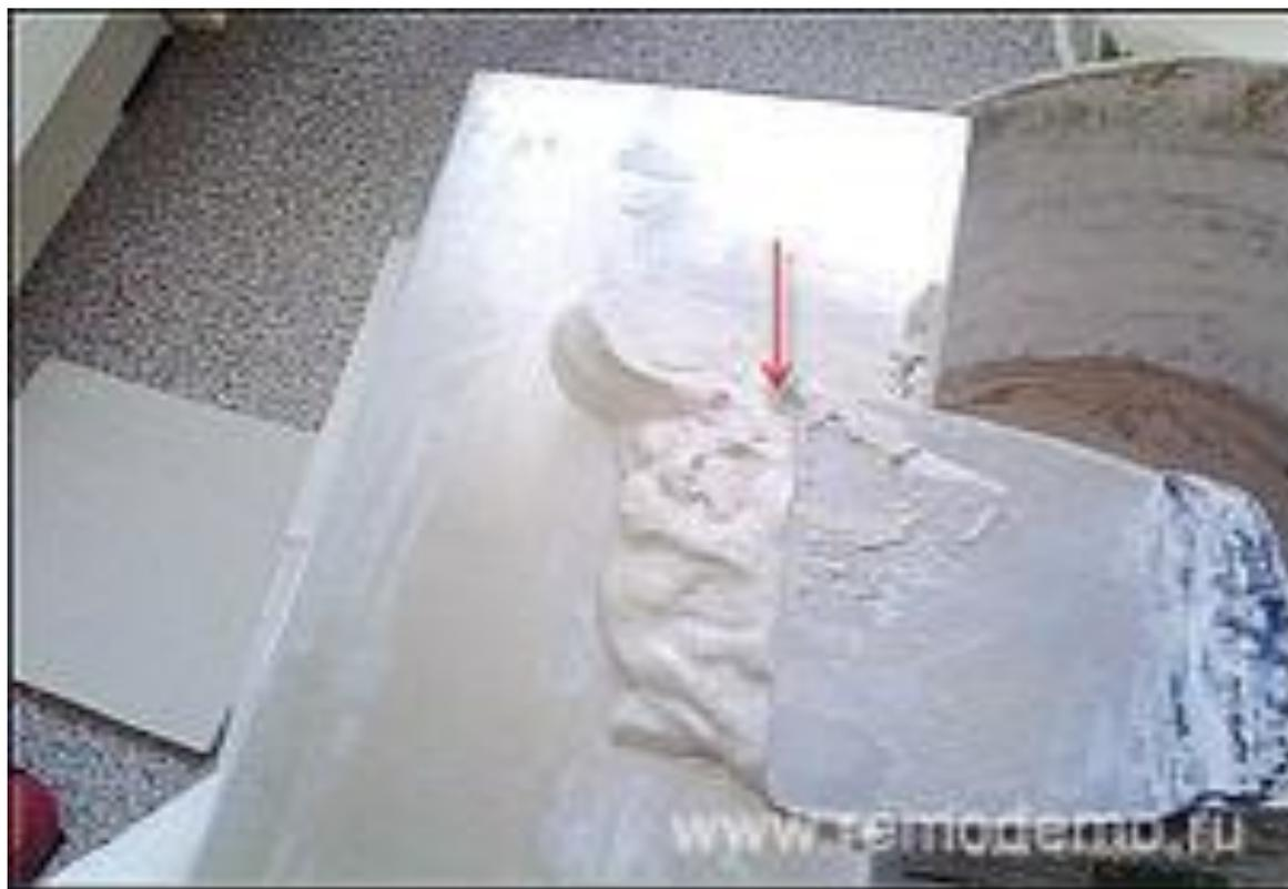
Подмазку выполняют движениями шпателя поперёк трещины, заполняя всю глубину.
