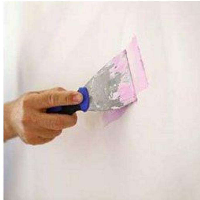
Затем движением шпателя вдоль трещины выравнивают слой пасты или шпатлёвки **заподлицо** с поверхностью.
