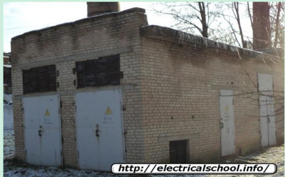
Трансформаторная подстанция 10/0,4 КВ
