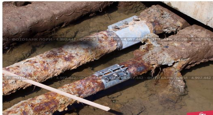
Ржавые водопроводные трубы с заплатками
