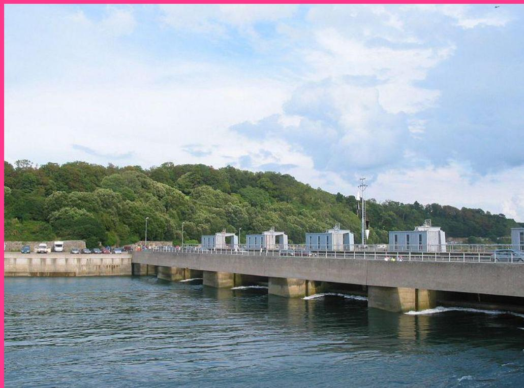
**Прили́вная электростáнция (ПЭС)** — особый вид гидроэлектростанции, использующий энергию приливов, а фактически кинетическую энергию вращения Земли. Приливные электростанции строят на берегах морей, где гравитационные силы Луны и Солнца дважды в сутки изменяют уровень воды. Колебания уровня воды у берега могут достигать 18 метров.
