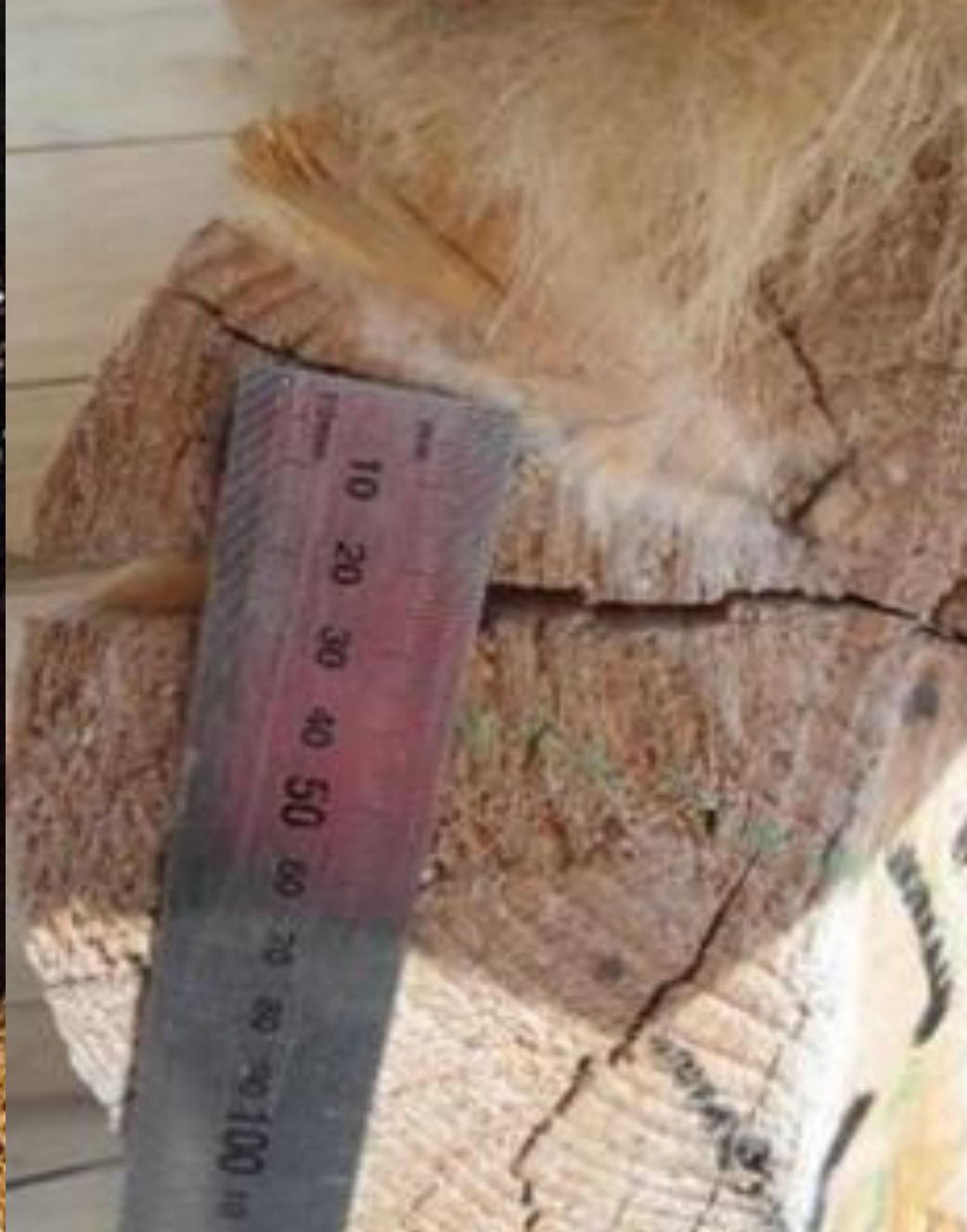
повреждения и дефекты обработки — повреждения при обработке инструментами и механизмами
