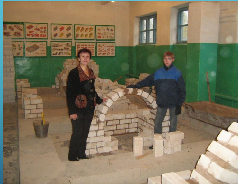
Кладка арочных перемычек
