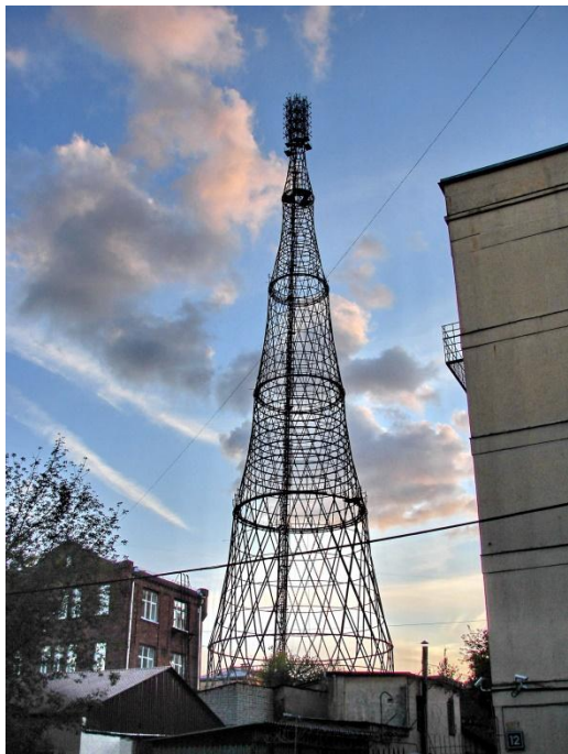
Шуховская Телебашня Москва
