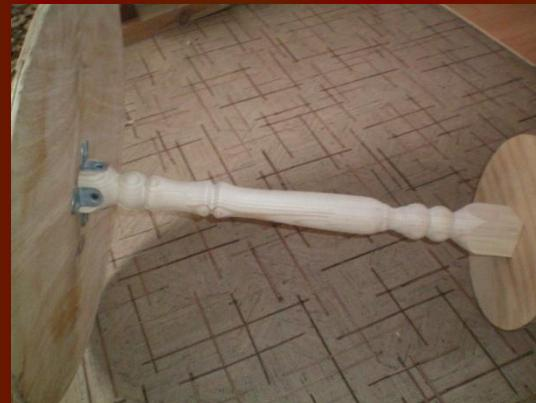
Прикрепляем нижнюю основу столика саморезом.
