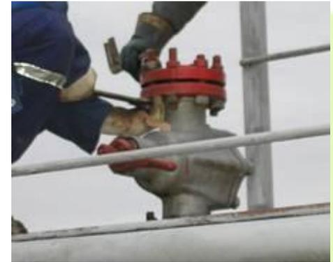
Ослаблять крепления необходимо, поворачивая гайки против часовой стрелки с помощью рожкового, торцевого или накидного ключей.
