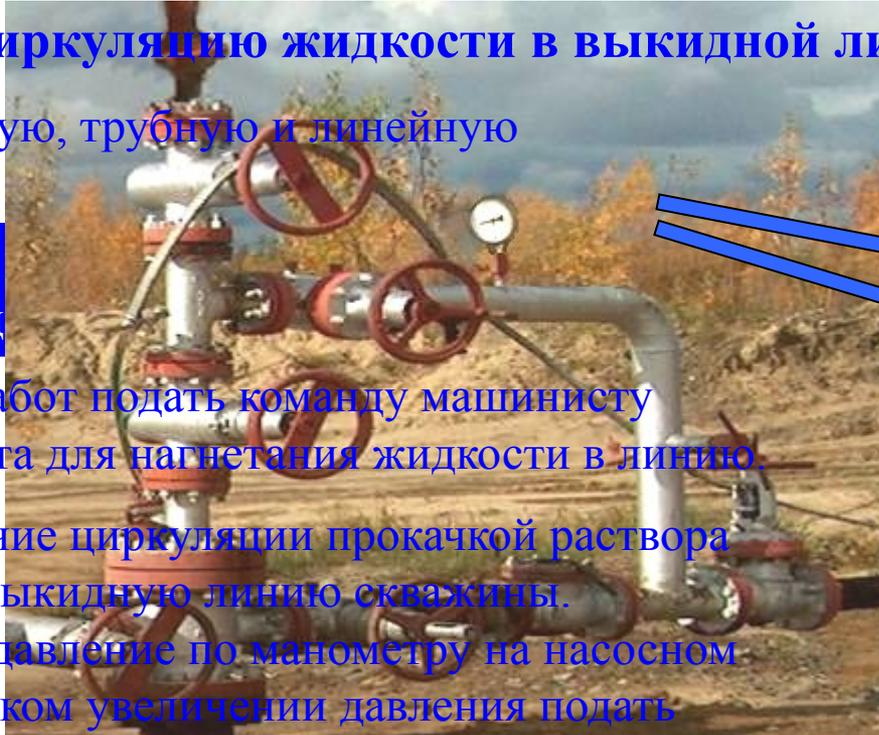
Наличие циркуляции подтверждается отсутствием превышения давления от первоначального на манифольде при прокачивании жидкости.
