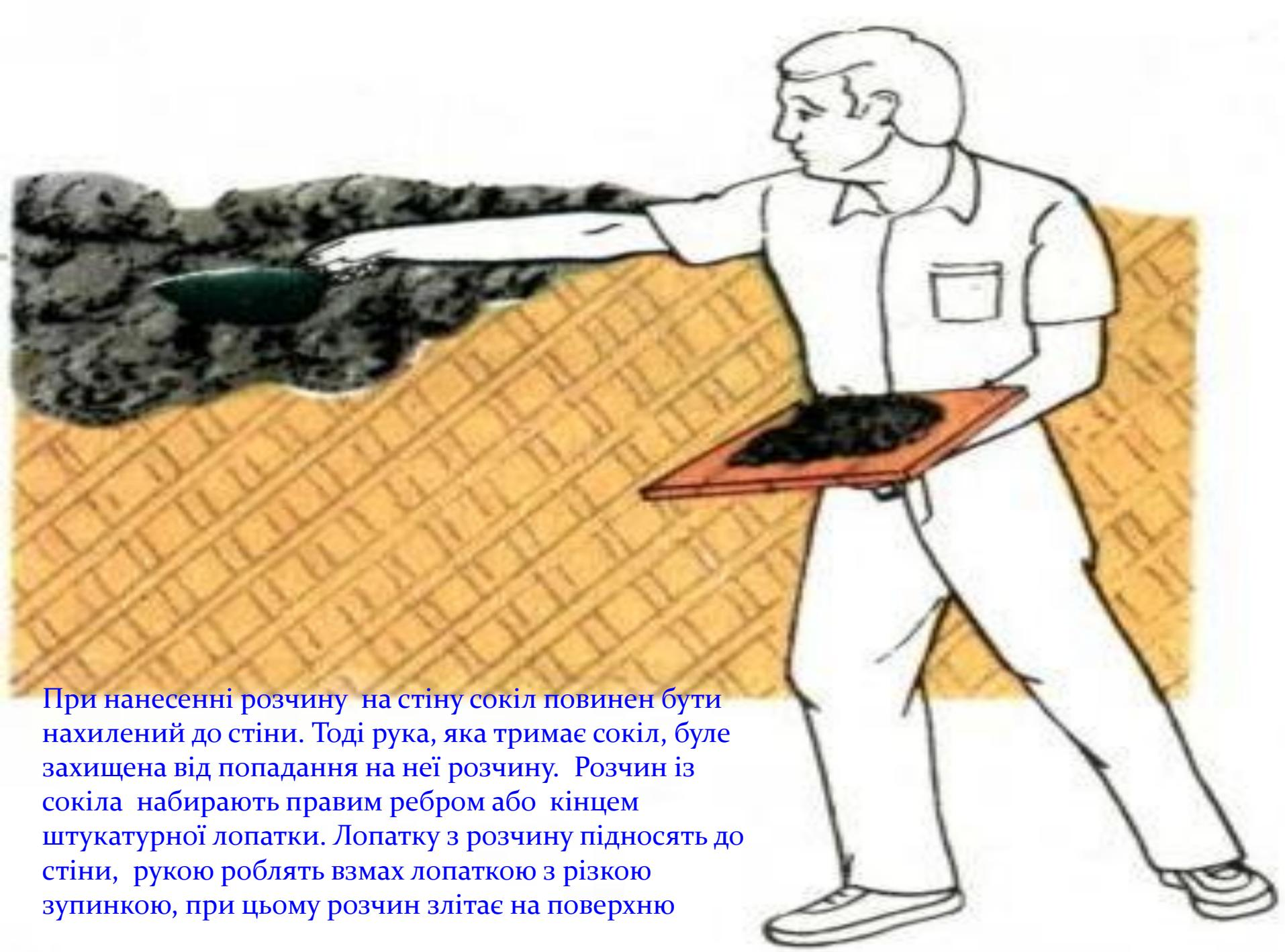
При нанесенні розчину на стіну сокіл повинен бути нахилений до стіни. Тоді рука, яка тримає сокіл, буле захищена від попадання на неї розчину. Розчин із сокіла набирають правим ребром або кінцем штукатурної лопатки. Лопатку з розчину підносять до стіни, рукою роблять взмах лопаткою з різкою зупинкою, при цьому розчин злітає на поверхню
