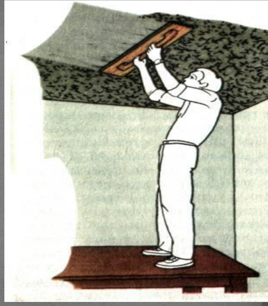
Ширина полотна півтерка повинна бути 120-200 мм., щоб на ньому можна було б вrimати більше розчину.
