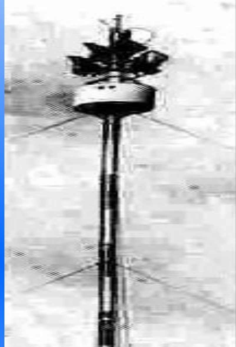
Станция линии радиорелейной связи
