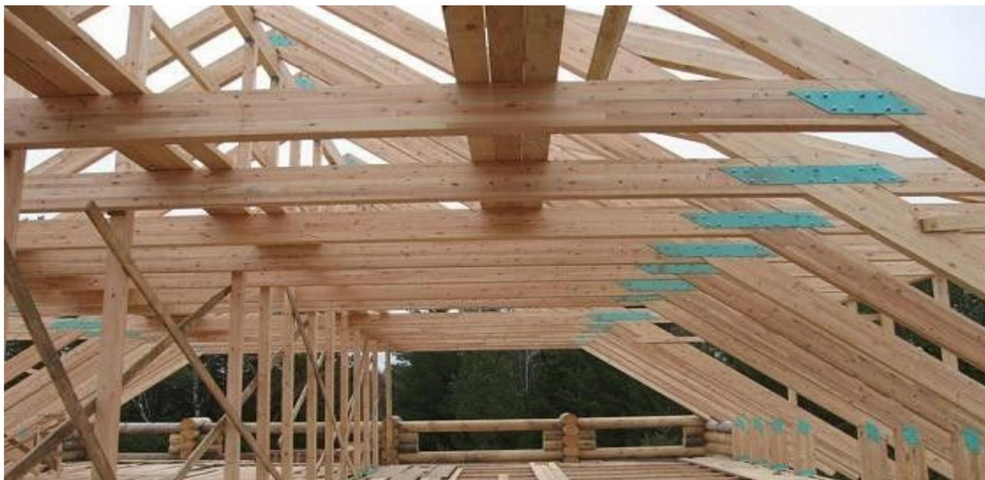
В фермах из брусьев для предотвращения появления значительных изгибающих моментов, возникающих вследствие несимметричного ослабления растянутого элемента, рекомендуется центрировать опорные узлы по оси, проходящей через середину ослабленного сечения нижнего пояса (рис.7а).
